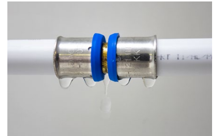
deutlich sichtbare Undichtheit bei nicht verpresstem Fitting
